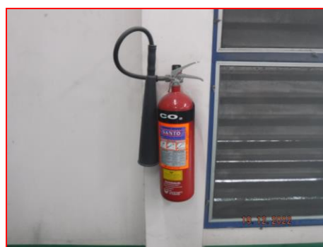
ภาพที่ 2.2-36 ถังดับเพลิงชนิด CO 2 บริเวณโรงคัดแยกเศษอะลูมิเนียม
